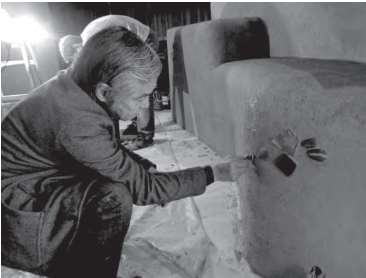
ストローベイルの土壁に“宝物”をはめ込んで遊ぶ
